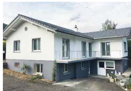
Nachher: Nach lediglich zweieinhalb Wochen erstrahlt das nun umfassend sanierte Wohngebäude nicht nur in frischem Glanz, es befindet sich jetzt auch energetisch auf dem neusten Stand.
